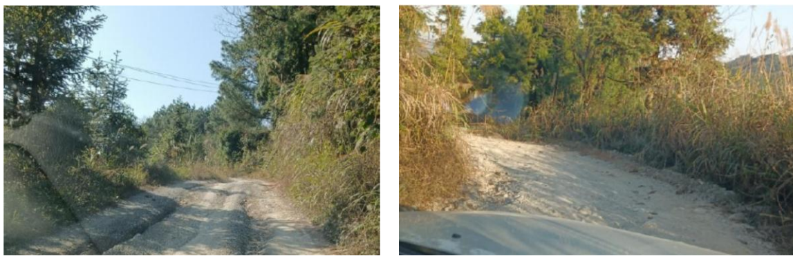
图 2.9-4 1 号风电场区进场道路改扩建段现状
