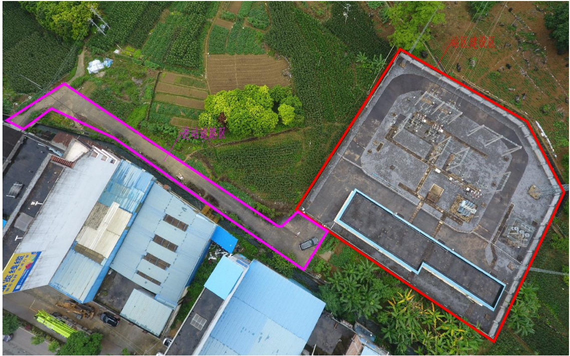
35kV 北三变电站现状
