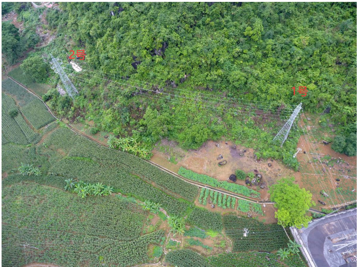
35kV 昌明线 1号塔、2号塔
