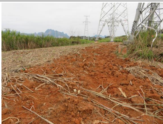
施工便道临时占地恢复
