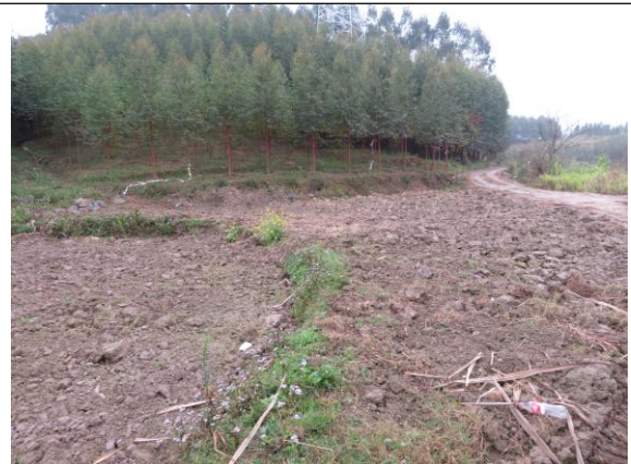
牵张场临时占地恢复
