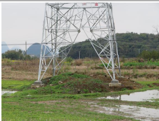
塔基恢复情况
