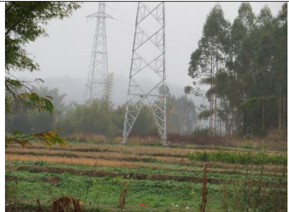
塔基恢复情况
