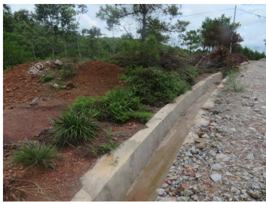
场内道路排水沟
