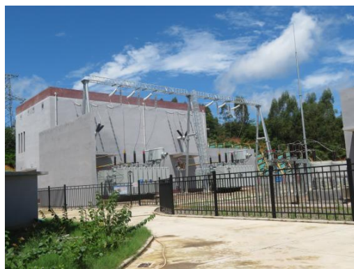
110kV 升压站主变
