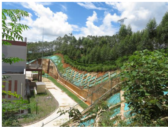
110kV 升压站站外边坡绿化
