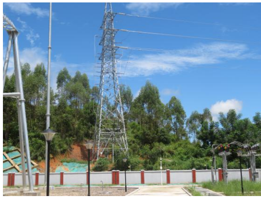
杆塔塔基处植被恢复
