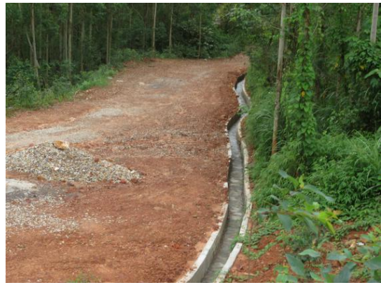
场内道路排水沟
