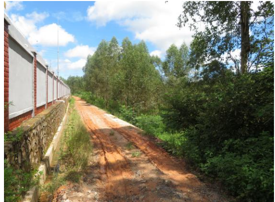
110kV 升压站站外植被恢复
