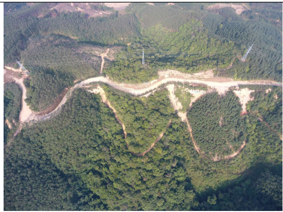
线路沿线处植被恢复
