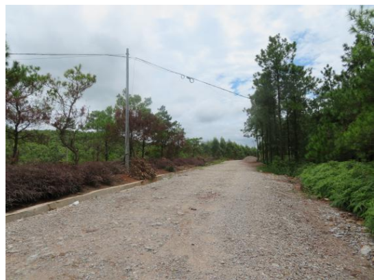
场内道路排水沟
