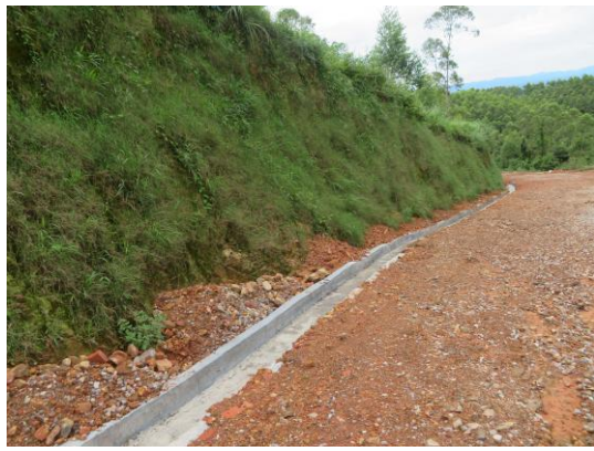
场内道路排水沟
