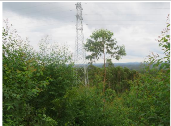
杆塔塔基处植被恢复
