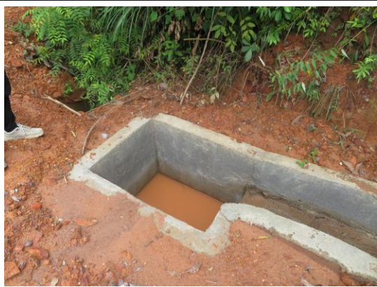
场内道路沉砂池
