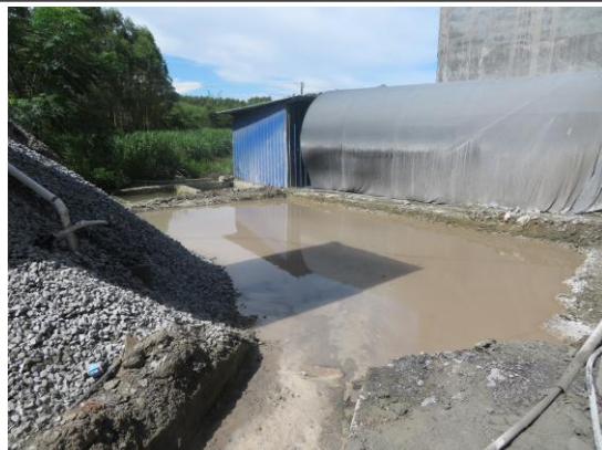
拌合站沉淀池
