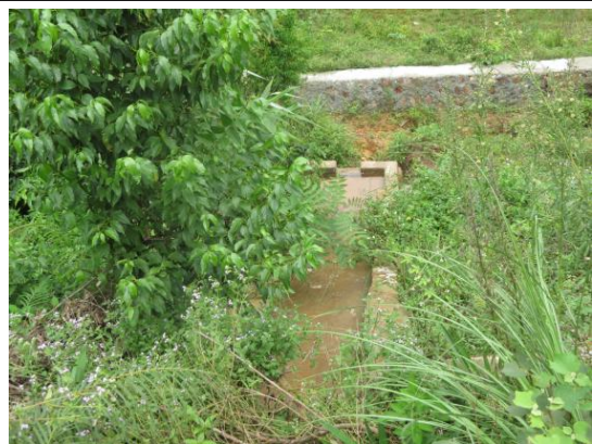
场内道路急流槽和沉砂池
