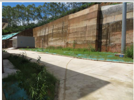
110kV 升压站内绿化
