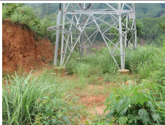
杆塔塔基处植被恢复
