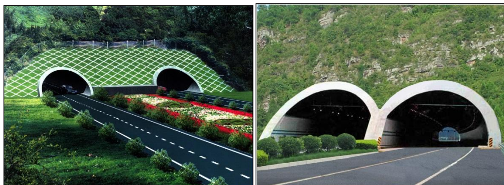
图 2.2-5 北环线隧道洞口型式和景观设计效果图
