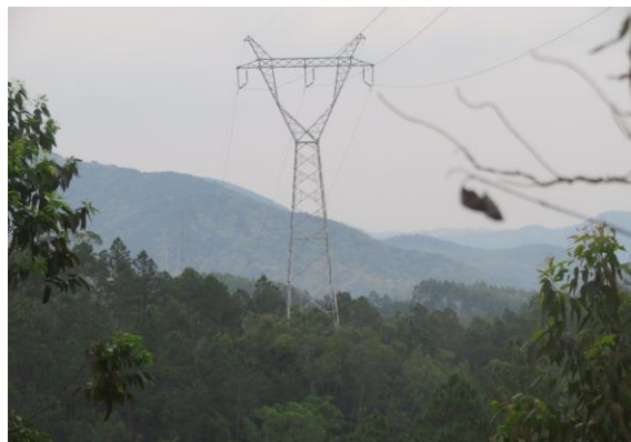
线路走廊植被恢复情况 1
