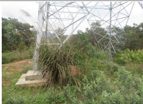
塔基处生态恢复 1
