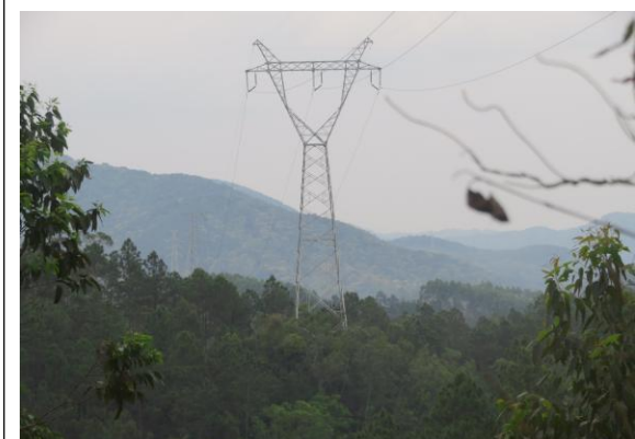
线路走廊植被恢复情况 1
